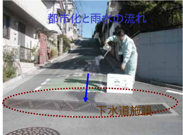
雨が下水道施設へ流入
