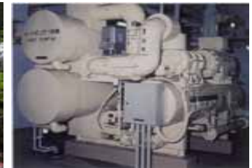
下水と熱交換を行うための ヒートポンプ
