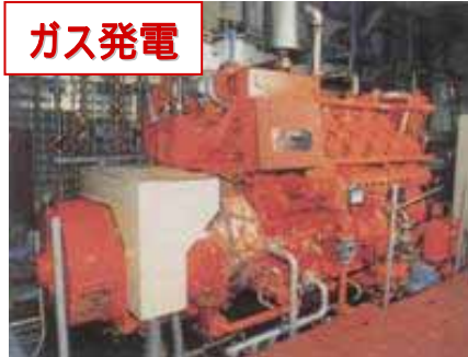
バイオガスを燃料としたガス発電 (東京都、横浜市など全国24処理場で実施)
