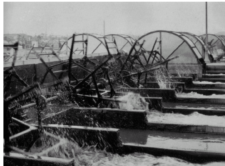
建設当時の三河島パドル式ばっき槽
